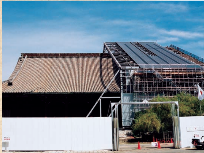
素屋根建設 平成12年9月14日
