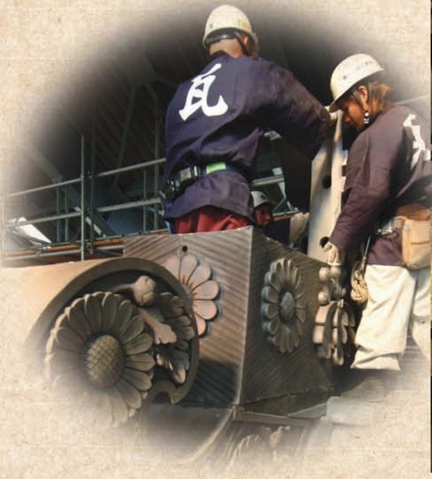
大棟獅子口据え置き 平成17年2月9日
